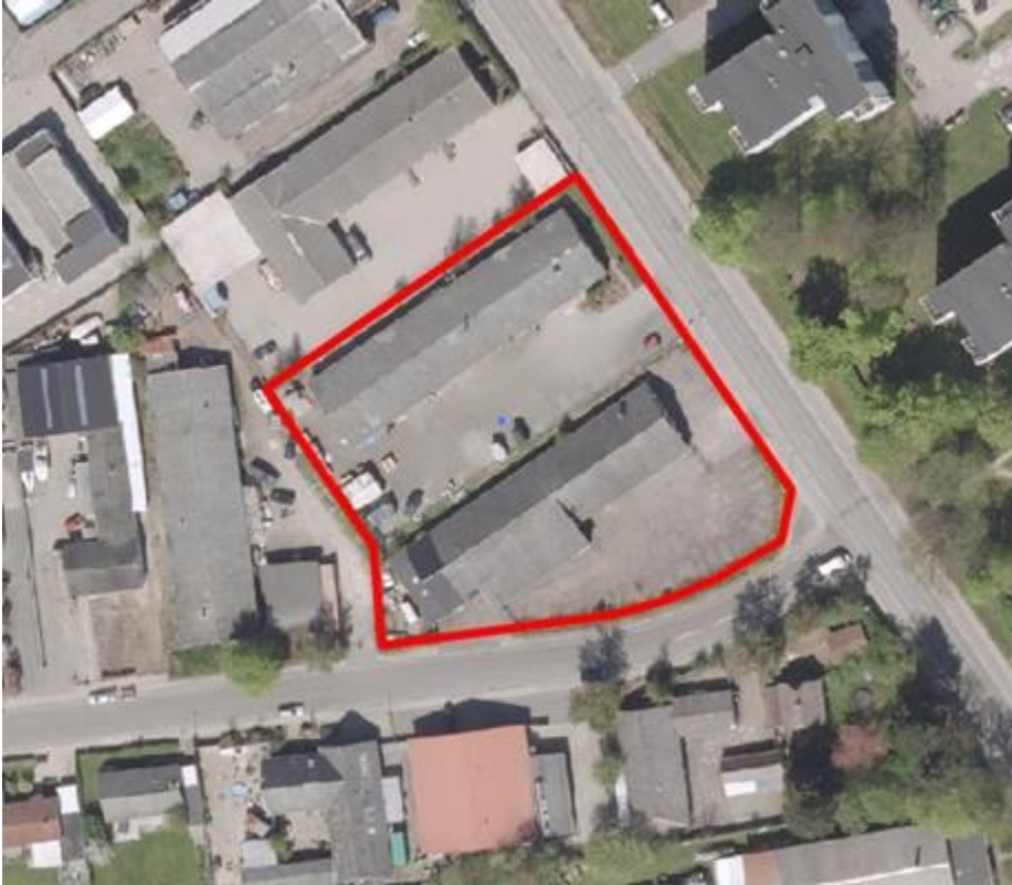
Luftfoto af Vejlegårdsvej 51 og Vejlegårdsvej 53/Torbenfeldvej 2
