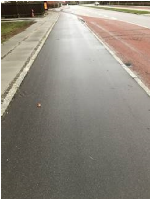
Foto 1: Eksempel på skadespoint 1 (Vallensbækvej)
