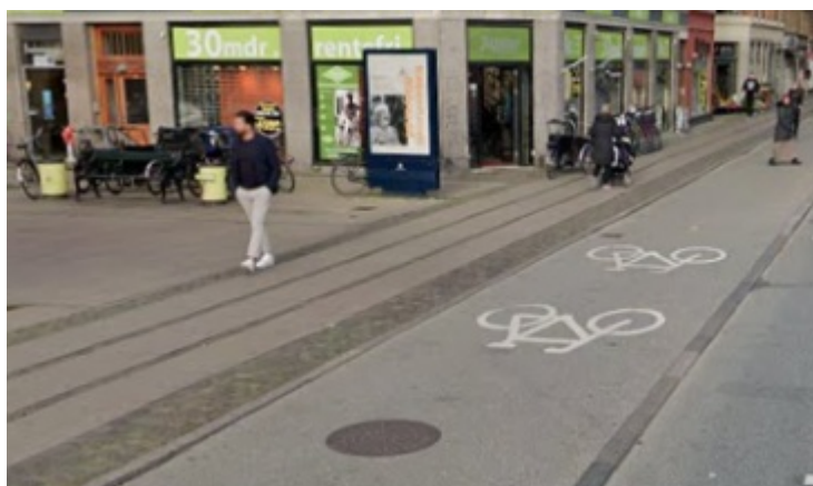
Billede 2: Eksempel på gennemført fortov og cykelsti
