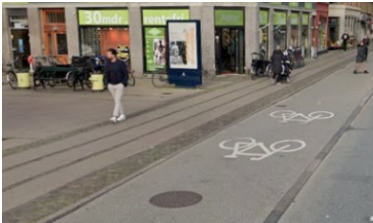
Billede 2: Eksempel på gennemført fortov og cykelsti
